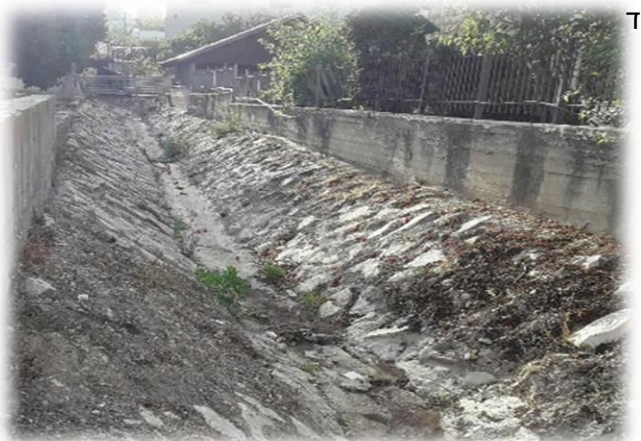
מבני חצייה וייצוב גדות המהווים הפרעה לזרימת הסדימנט והצומח המעוצה ברמה נמוכה (א) ובינונית (ב). ייצוב גדות (ג) וריצוף תשתית (ד) במקטע 2
